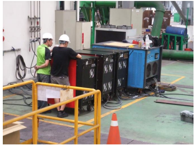
CUT-1000i 現場實況
