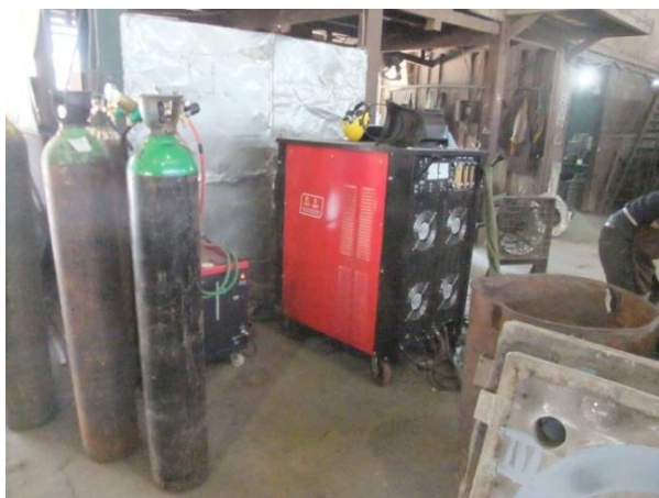
鑄造物切除工作現場
